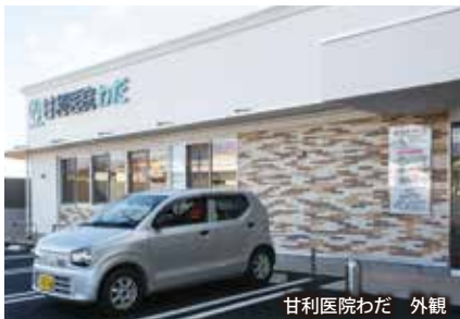
甘利医院わだ 外観
